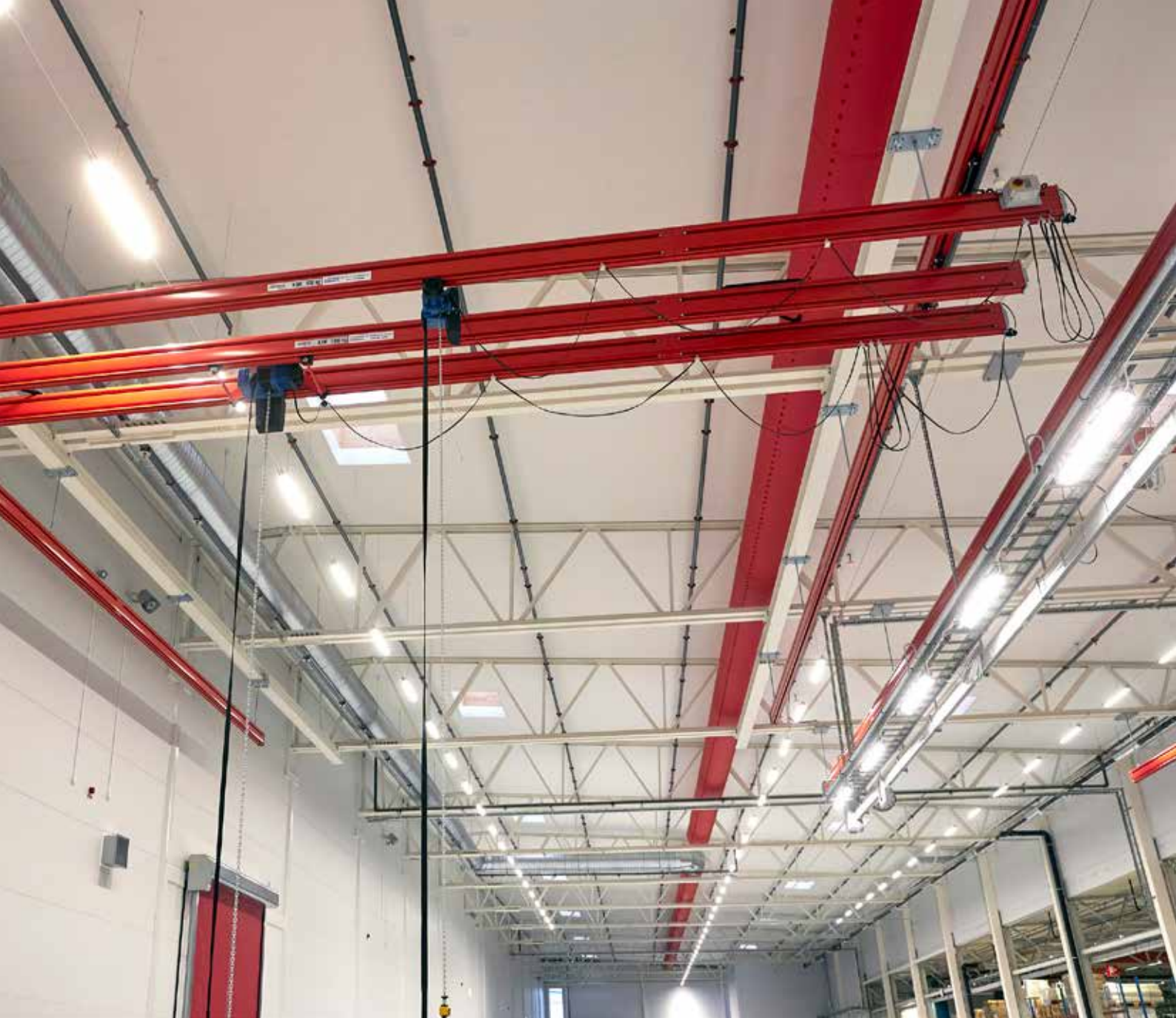
Lyft och transport mellan olika stationer blir smidigt med KBK lättlastsystem.
