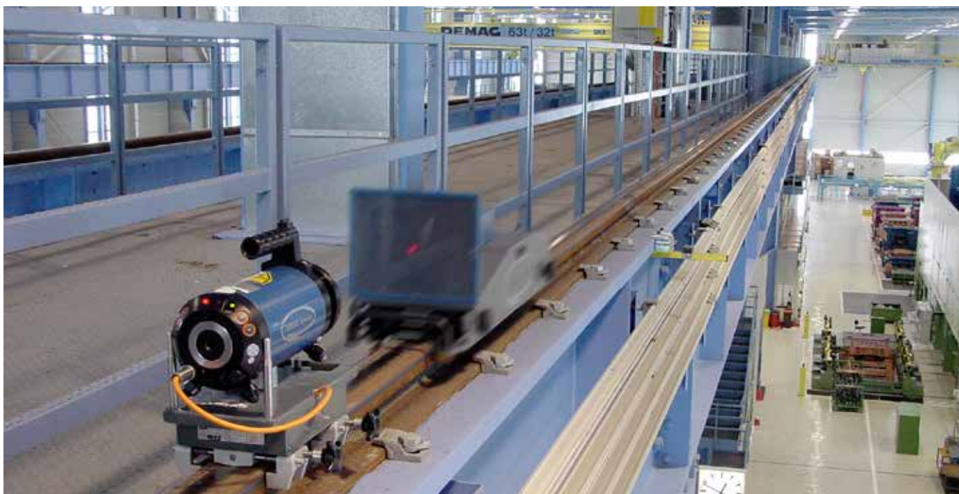
Kranbanemätningen görs med hjälp av en självutjämnande laser och en mätvagn som är monterade på rälen.
