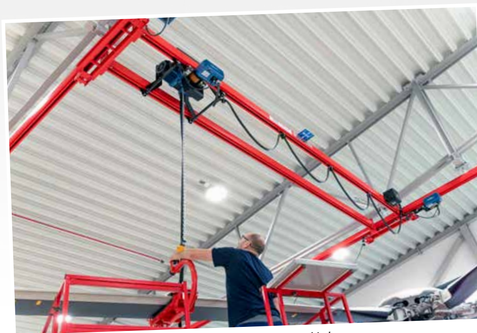
Mattias Olofsson, SMA Maintenance, testar att lyfta av ett rotorblad.
