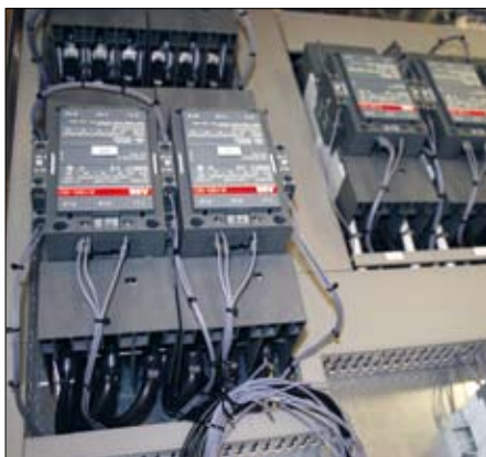
DTC gör många ombyggnationer av el.
